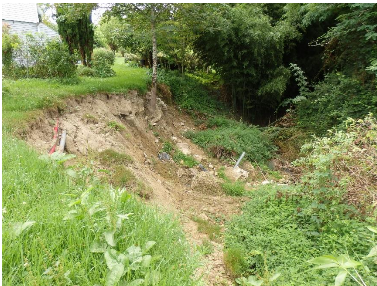
Effondrement massif à Omet
