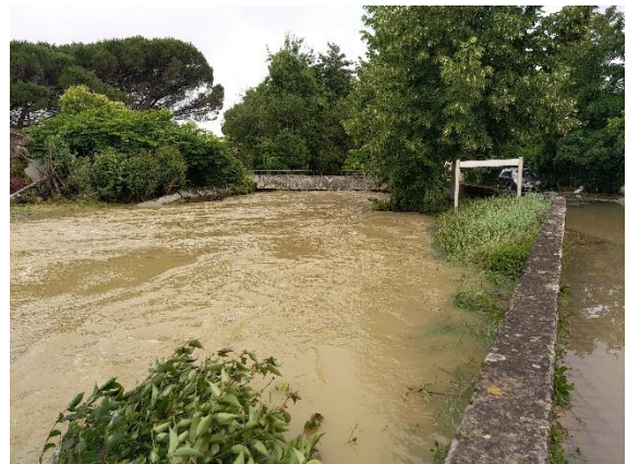
L'aval du pont du bourg de Latresne
