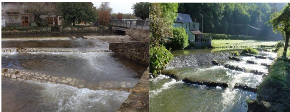
Photo 5 : Vue de seuils triangulaires avec échancre et de prébarrages
