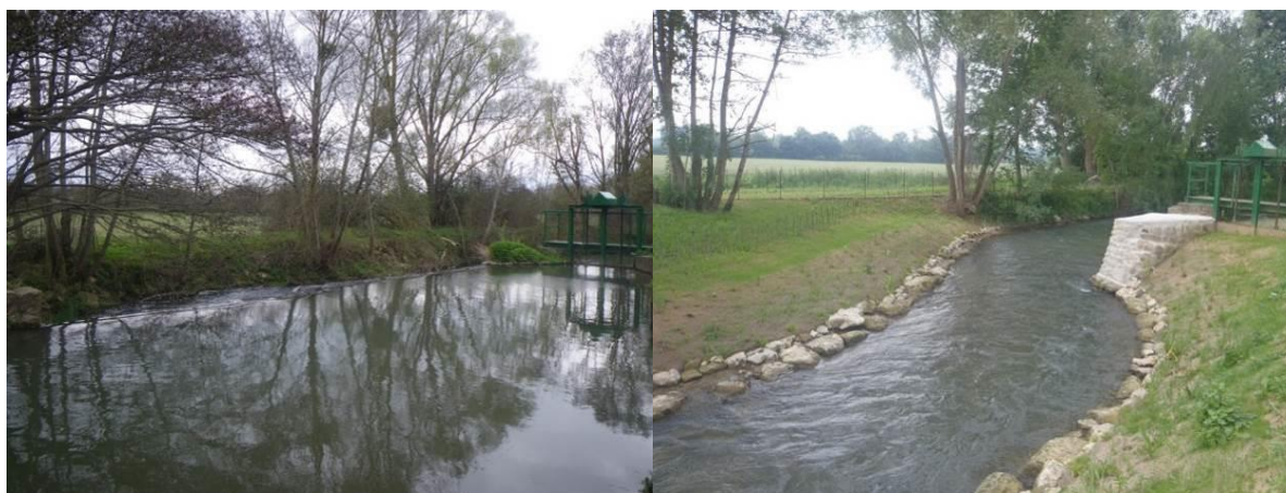
Photo 4 : Exemple d'effacement réalisé par SEGI au Moulin de Longpont situé sur la combe des Ormes-sur-Voulzie (77)
