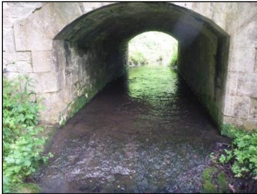
Station Soye_1 – Vue vers l'amont – mai 2023
