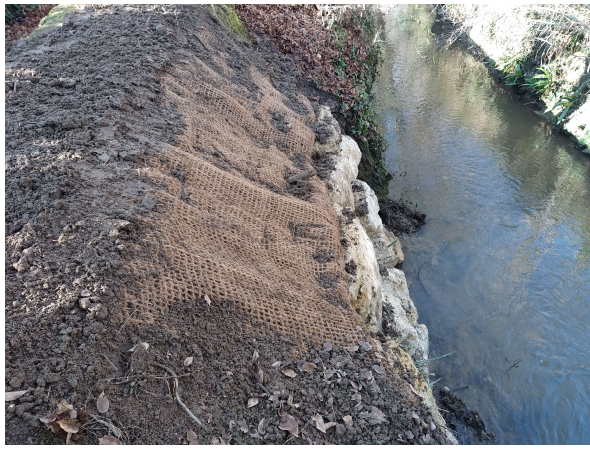
technique mixte en enrochement/végétalisation
